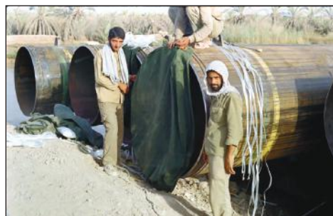
بستن برزنت روی لوله‌ها
