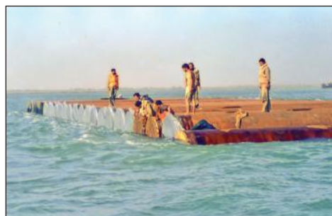
غرق کردن لوله‌ها
