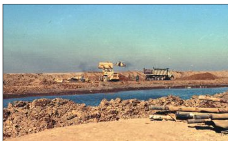
جاده سازی در منطقه عملیات
