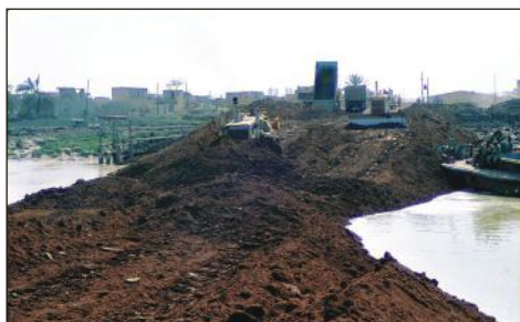
احداث سد خاکی روی رودخانه بهمنشیر
